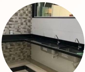
Reforma de banheiros
