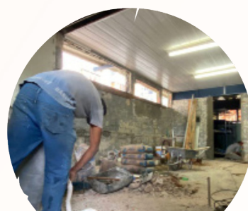
Reforma de salas de aulas e salas administrativas
